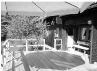
Die fertige Terrasse ...
