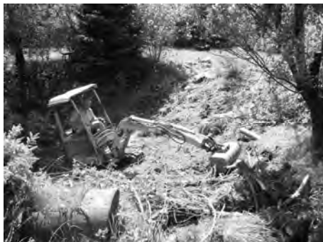
Umbau in vollem Gange ...
