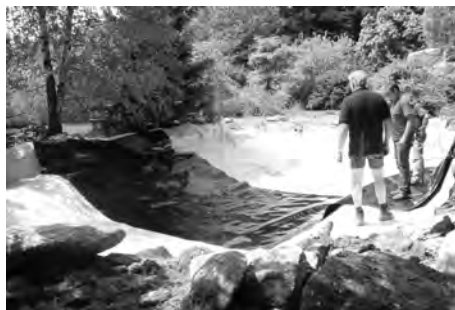
Verlegen der Folie
